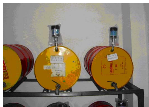
图 2 已启用的油品存储桶安装干燥型呼吸帽
